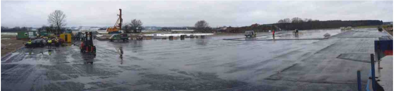
Blick auf den fertigen Bohrplatz in Mauerstetten
