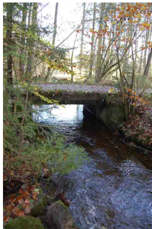
Brücke über den Rötzbach
